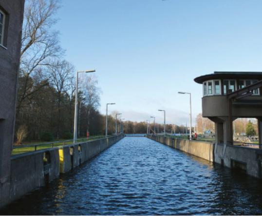
Die Anlage wurde 1925–1929 als Zwillingsschachtschleuse errichtet und besteht aus zwei nebeneinanderliegenden Kammern. Die Sonderbetriebsweise spart ca. 50 % Wasser gegenüber Einzelschleusungen. In der Regel steht eine Kammer auf Oberwasser, die andere auf Unterwasser. Beim Schleusen wird gleichzeitig in beiden Kammern gearbeitet. Erst wird der Wasserspiegel beider Kammern ausgeglichen. Dann wird die eine Kammer ins Unterwasser entleert und die andere aus dem Oberwasser gefüllt. Foto: Biberbaer
