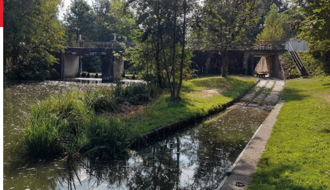
Das Sperrwehr oberhalb von Märkisch Buchholz mit der Slipanlage für Kleinfahrzeuge.
